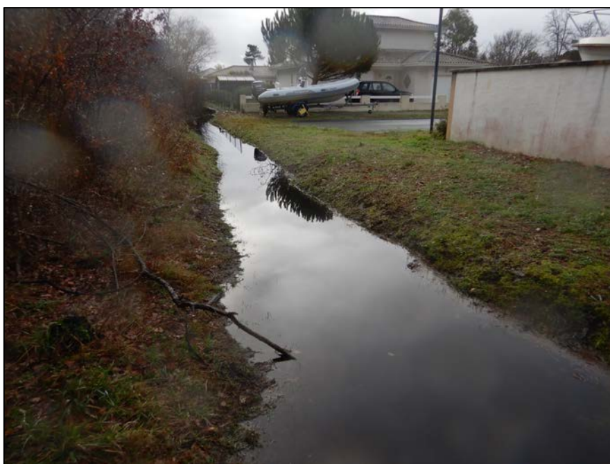
Figure 7 : Photos de deux fossés présents sur le site d'étude
