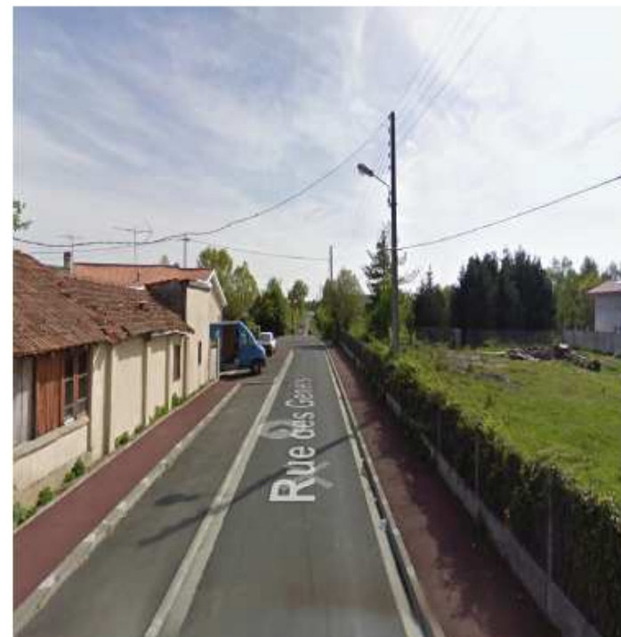
VUE 3 - RUE DES GENÊTS
