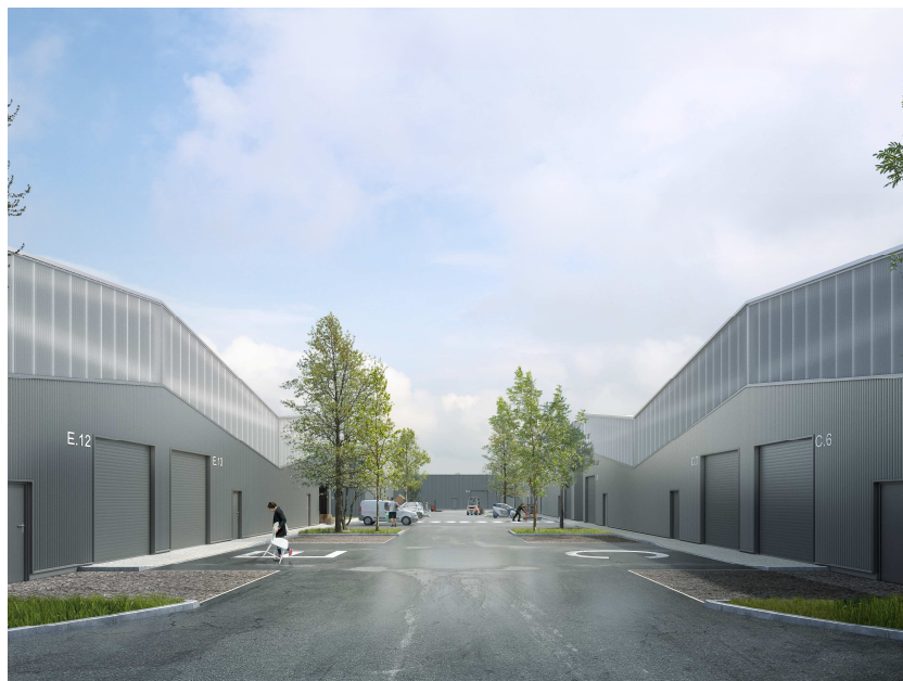
Voiries internes au parc Ecchobloc
