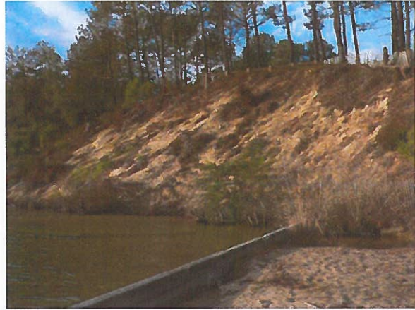
Erosion principale de pied de talus
