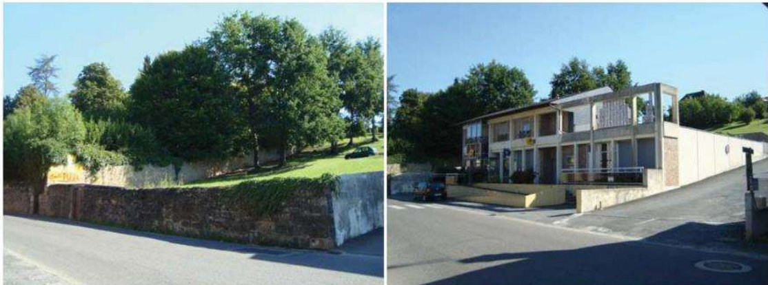
Vue de la partie NORD OUEST de la zone depuis la Route du Docteur Soufron, à proximité de la Poste
