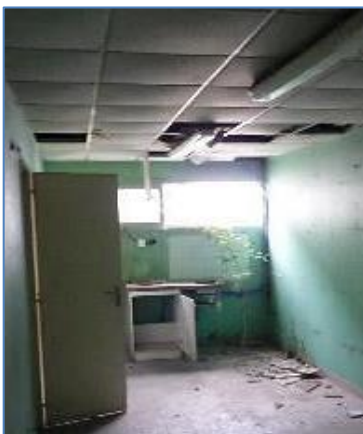
Ouvertures dans un faux-plafond du bâtiment n°3, difficilement prospectables à la simple vue – A. Liger, Écosphère
