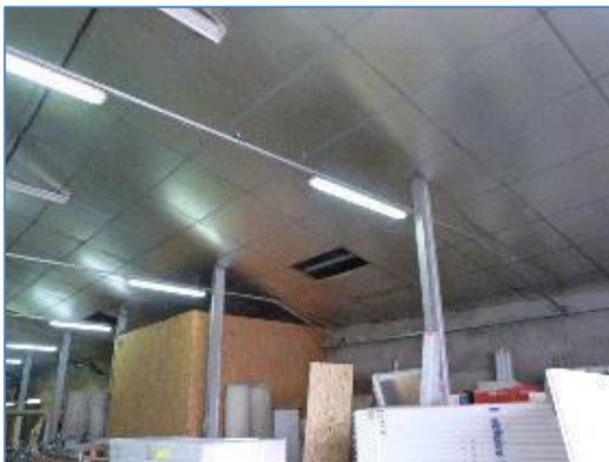
Vue sur le plafond en plaques de métal de la partie Sud-ouest de la partie n°5 – A. Liger, Écosphère
