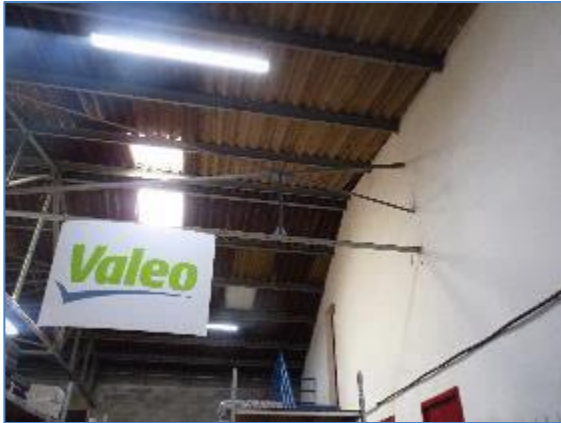
Vue sur le plafond en tôles plastiques de la partie Sud-est du bâtiment n°4 – A. Liger, Écosphère
