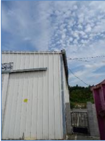
Vue sur l'avant du bâtiment n°2 – A. Liger, Écosphère
