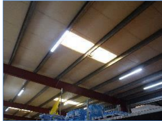
Vue sur le plafond en toile plastique de la partie Nord-ouest du bâtiment n°4 – A. Liger, Écosphère
