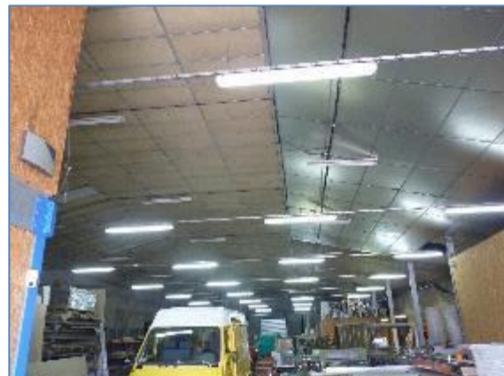
Vue sur le plafond en plaques de métal et placoplâtre du bâtiment n°5 – A. Liger, Écosphère
