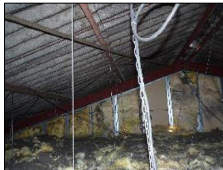
Vue sur les combles du bâtiment n° 3 (source : Écosphère)
