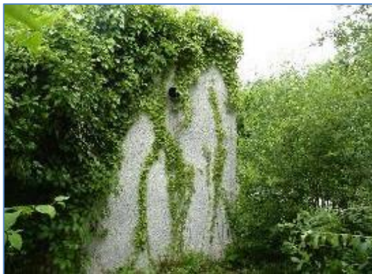
Vue sur l'entrée du tuyau d'aération du bâtiment n°1 – A. Liger, Écosphère
