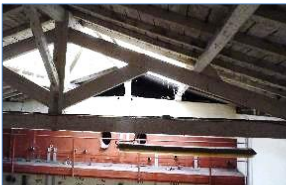
Vue sur la charpente du toit de la partie Sud-ouest du bâtiment n°9 : combles et planches à interstices favorables aux Chiroptères – A. Liger, Écosphère
