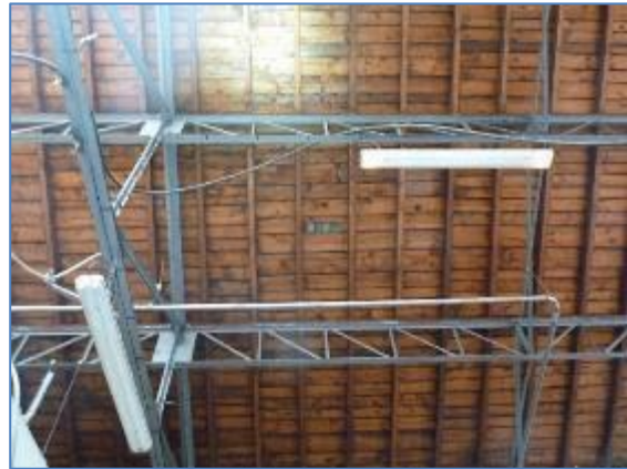
Vue sur le plafond en planches de bois du bâtiment n°5, présentant d'assez nombreux interstices favorables au gîte de Chiroptères – A. Liger, Écosphère
