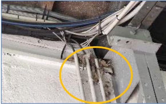
Reste d'un ancien nid au niveau de l'entrée du bâtiment n°6 – A. Liger, Écosphère
