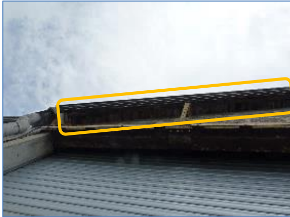
Vue sur l'entrée du bâtiment n°6, et de la présence de planches en bois avec interstices, pour certaines, favorables au gîte de Chiroptères – A. Liger, Écosphère
