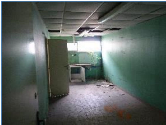
Vue sur un des couloirs du rez-de-chaussée du bâtiment n°3 – A. Liger, Écosphère
