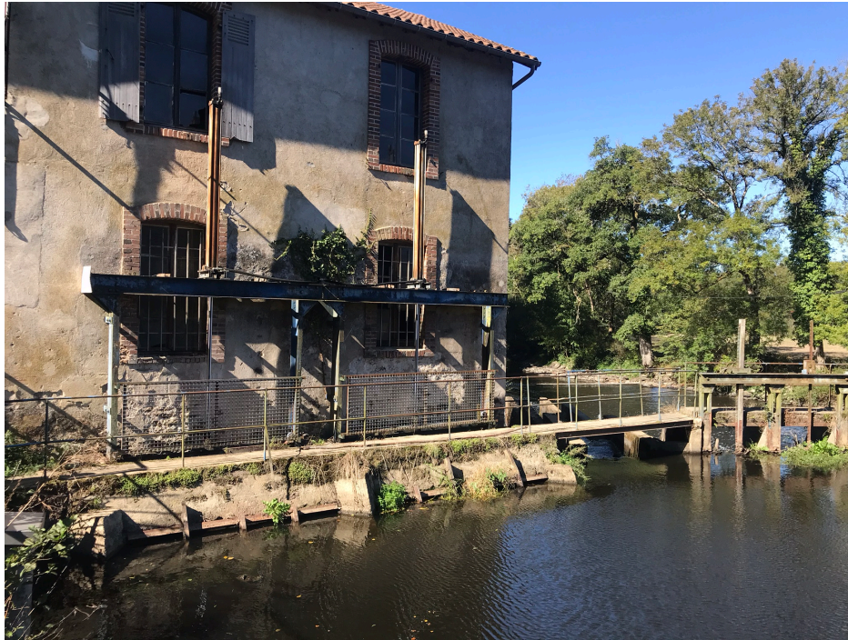
Figure 3 : prise d'eau et vannes de décharges de la centrale
