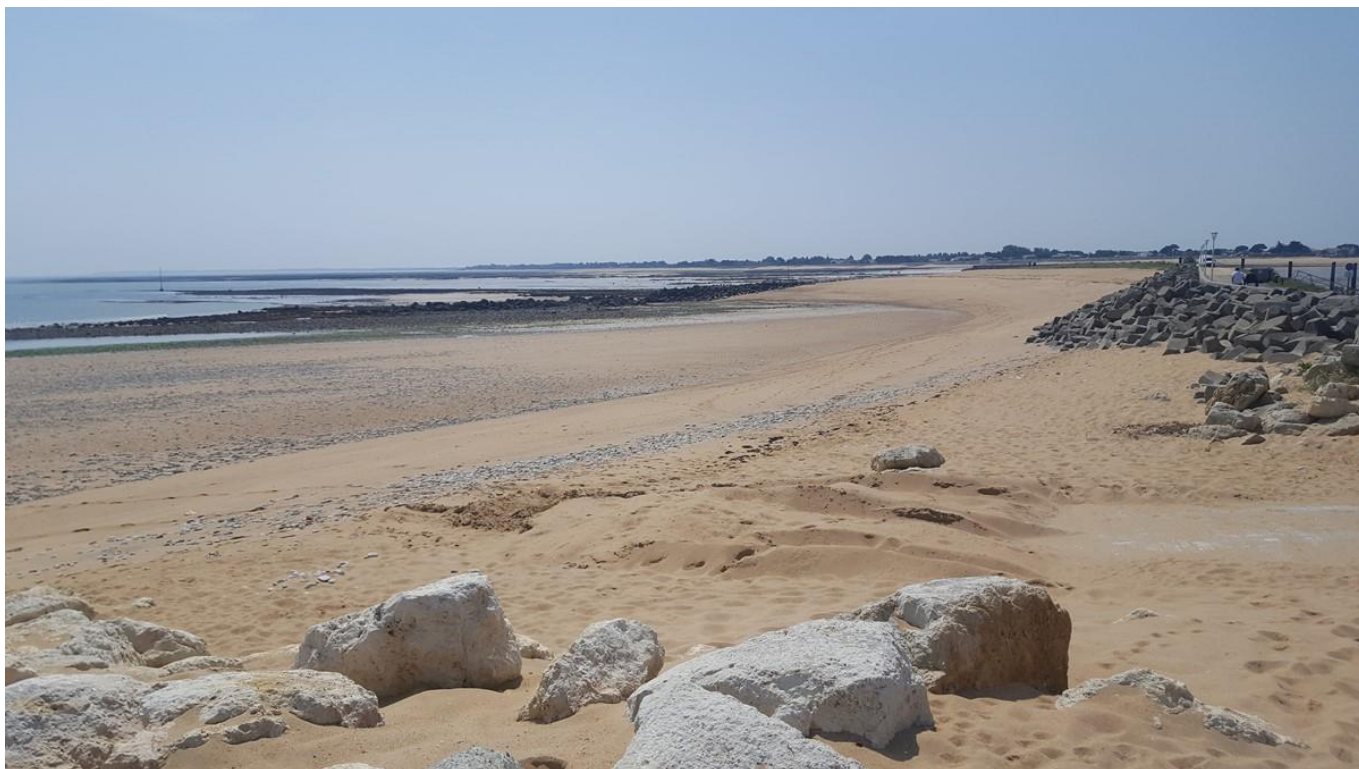
Photo 1 : Vue depuis l'accès au casier n°2 derrière le port de plaisance
