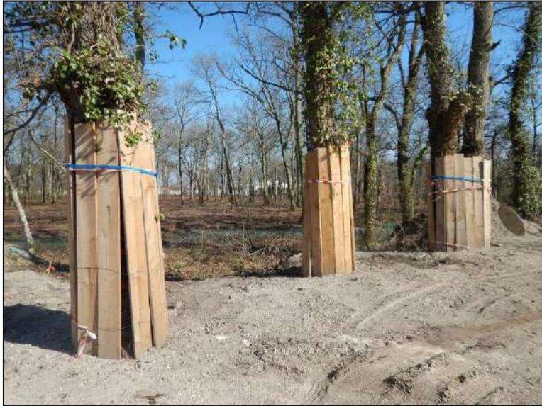
*Figure 19 : Dispositif de protection des arbres remarquables sur chantier (Source : ENVOLIS)*
