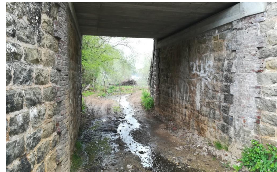
Passage sous la voie ferrée (8)
