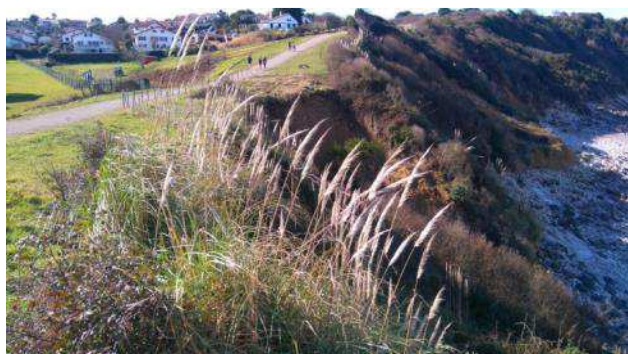
Secteur amont de la falaise
