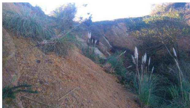
Secteur de l'ancien rejet d'eaux pluviales
