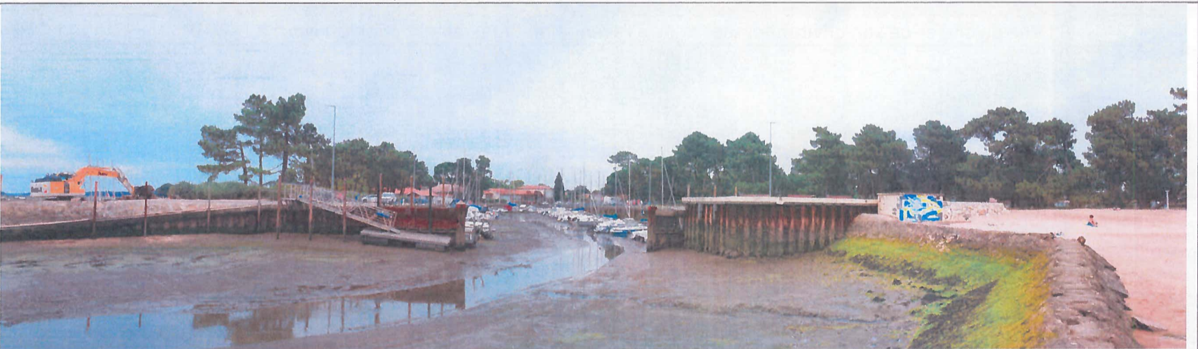
12 : Vue du port et de son environnement depuis le chenal en direction du Nord (06/2019)
