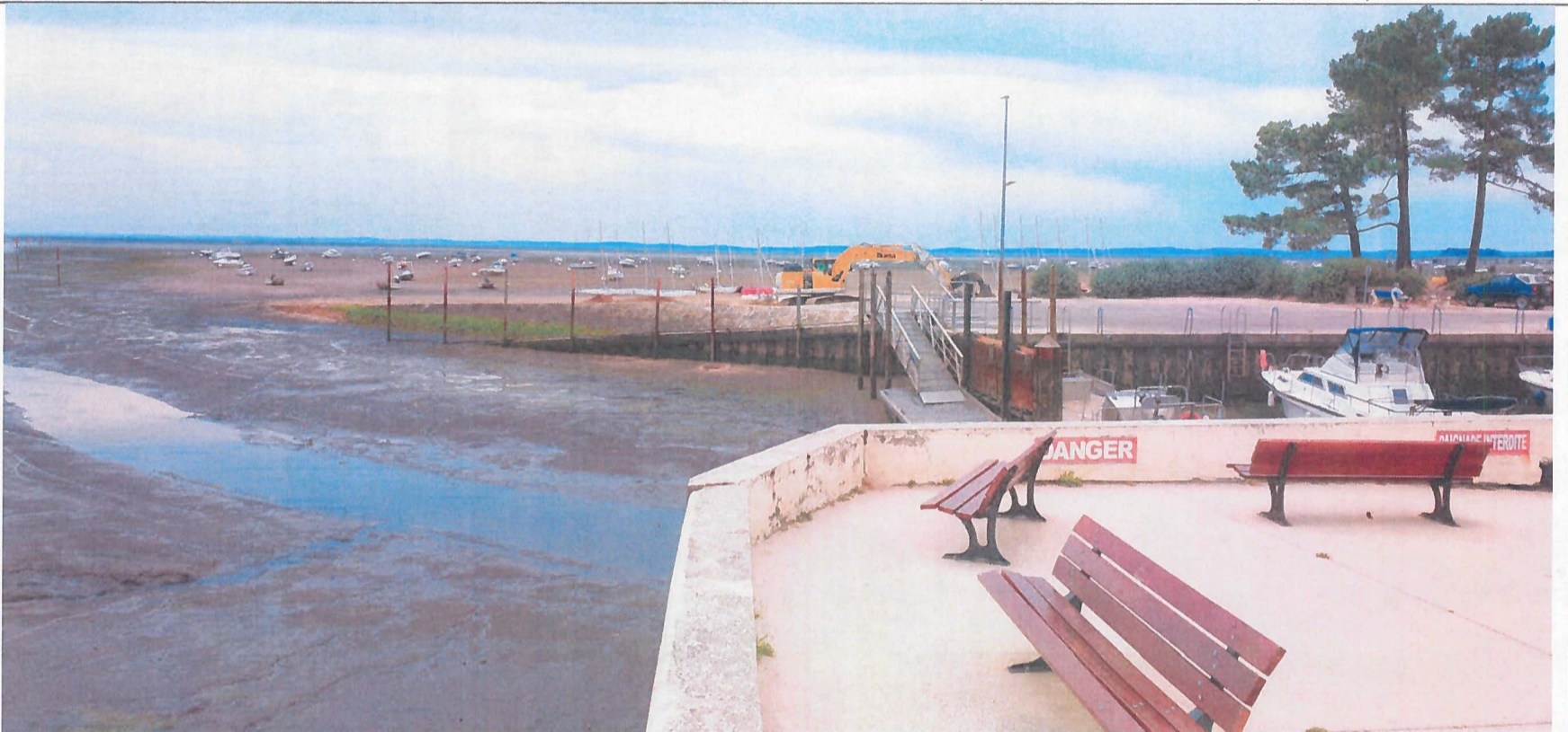
11 : Vue de la darse du port et de son environnement en direction du Sud-ouest (06/2019)
