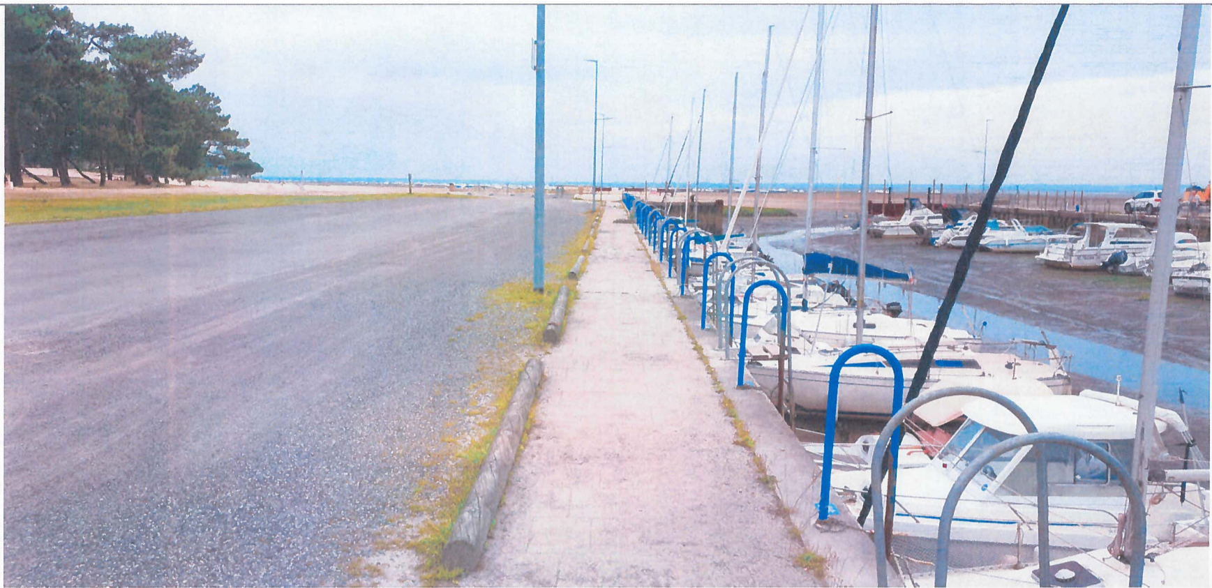
7 : Vue du site et de son environnement depuis l'avenue du Bety en direction du Sud (06/2019)
