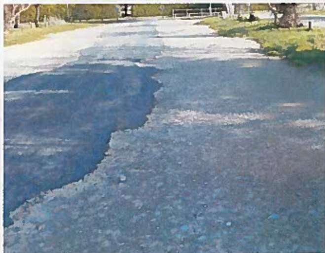
Présence de nids de poule à la fois sur la voie de circulation en enrobé et sur les zones de stationnement en calcaire.
