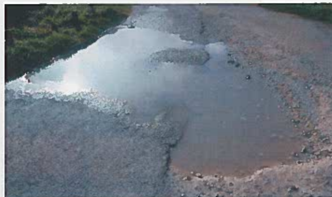
Présence de nids de poule à la fois sur la voie de circulation en enrobé et sur les zones de stationnement en calcaire.
