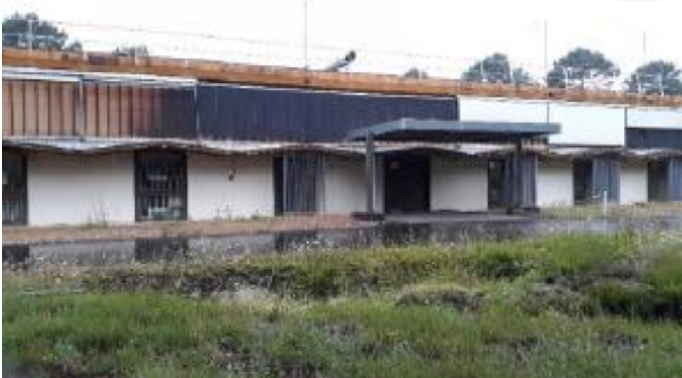
Photographies du bâtiment 300 existant à démolir – juin 2019
