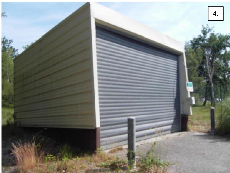
Photographie du bâtiment 180 à démolir – juin 2019
