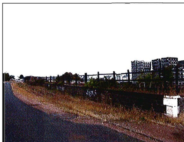
Vue vers l'Ouest (extrémité Est du site) : plateforme en enrobé avec ancienne voie V13, quai de chargement avec stockage blocs béton
