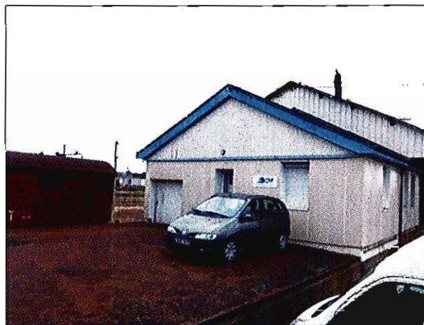
Vue vers le Nord-est depuis le parking de la gare: ancien quai, ancienne halle marchandise avec locaux de l'entreprise SGW
