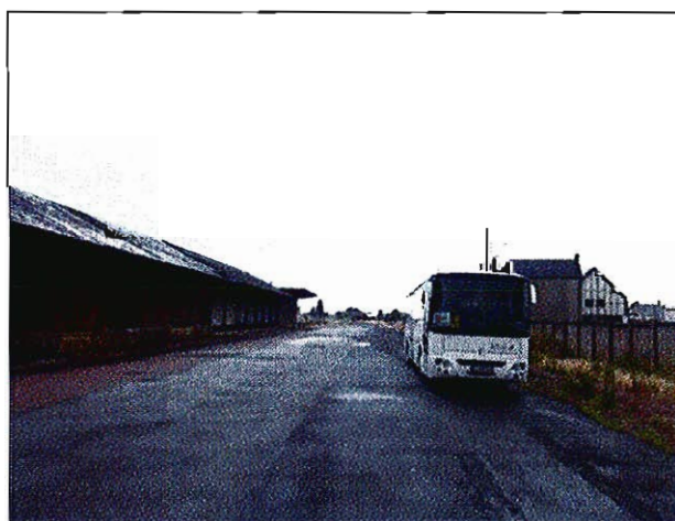
Vue vers l'Est : ancienne halle marchandises inoccupée, plateforme en enrobé, ancienne voie ferrée V13 (à droite)
