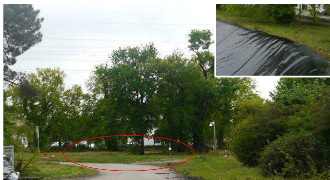
Vue 1 : localisation du bassin et nature artificielle des berges.
