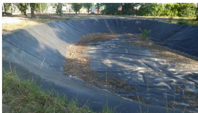
Bassin à sec le 10/07/2018.
