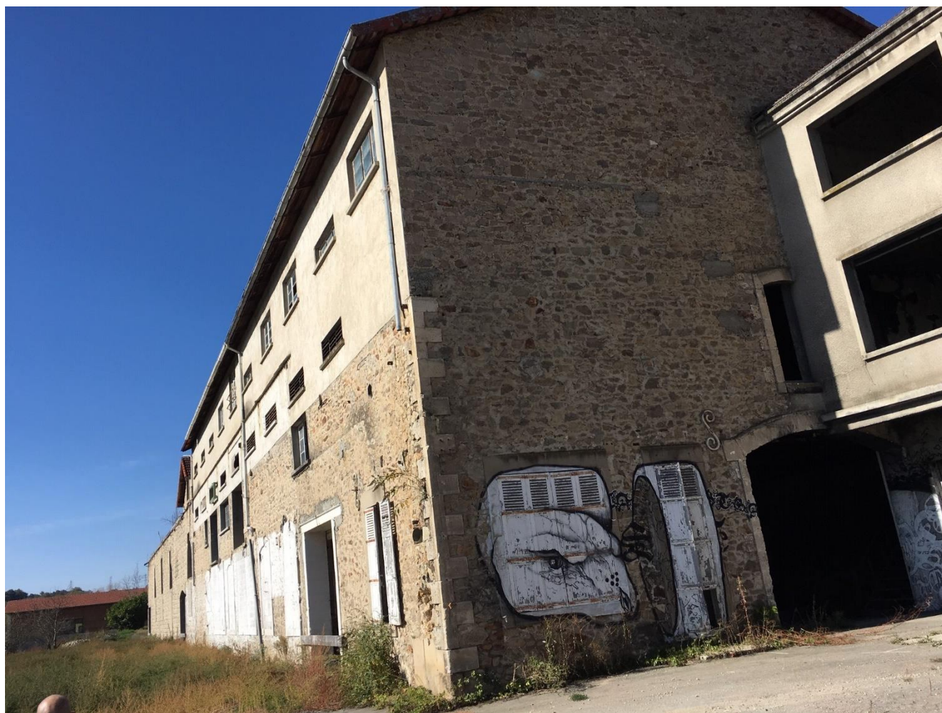
Photographie 1 : En arrivant par le Chemine Notre-Dame au Goth, premier bâtiment (côté Est)
