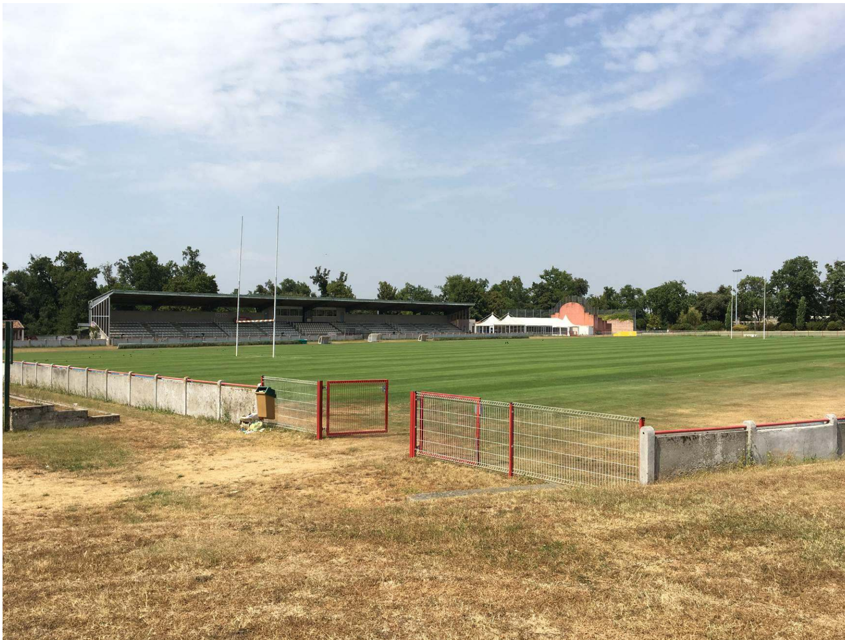
Photographie 1 : site projet vu de l'intérieur du Parc des sports, vers le terrain d'honneur et la tribune principale - date 25 juillet 2019
