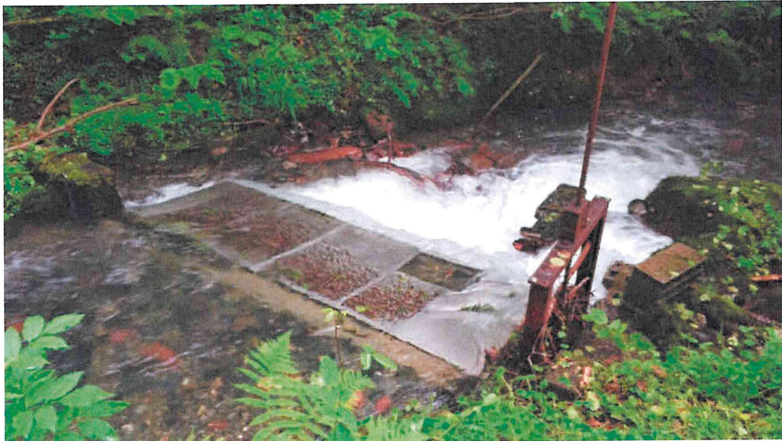
Vue du seuil depuis la rive droite
