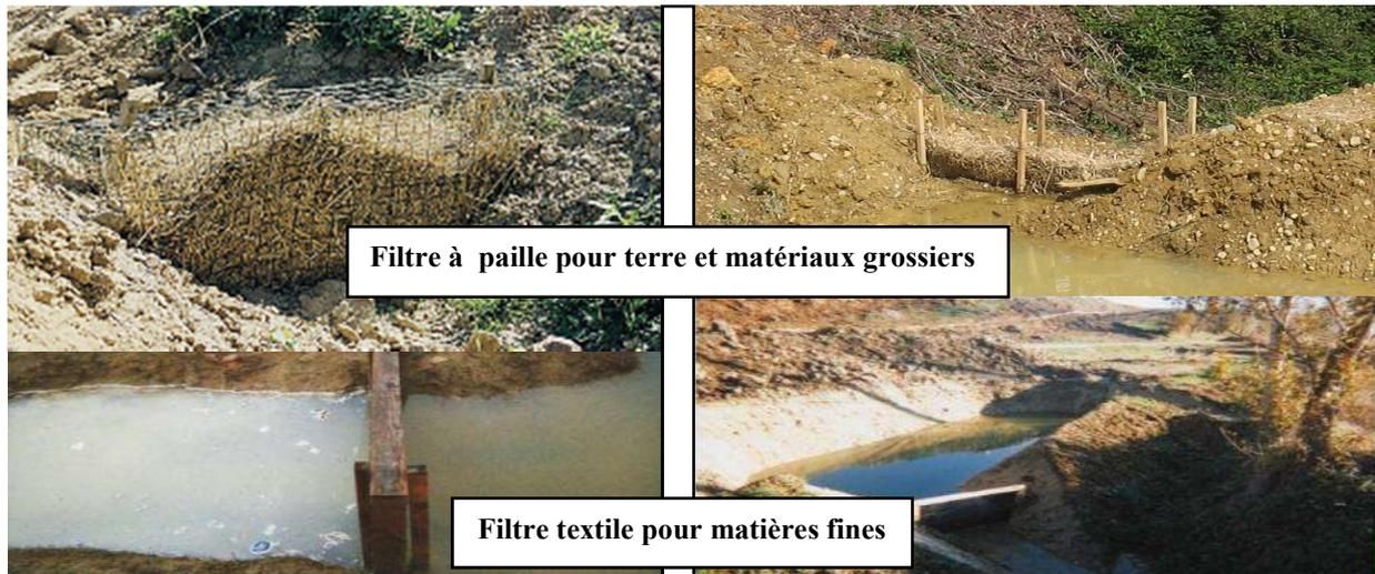
Photos n° 4, 5, 6 & 8: Aménagements nécessaires à l'atténuation des impacts de la conduite.
