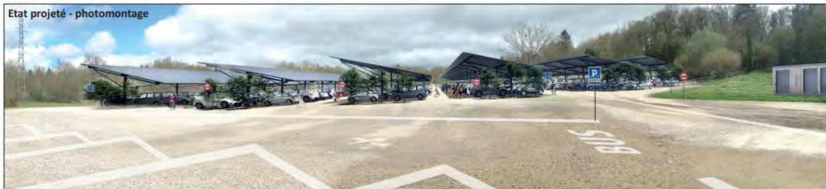
Vue proche : Point de vue actuel et simulation avec depuis le parking (source I'M IN ARCHITECTURE)
