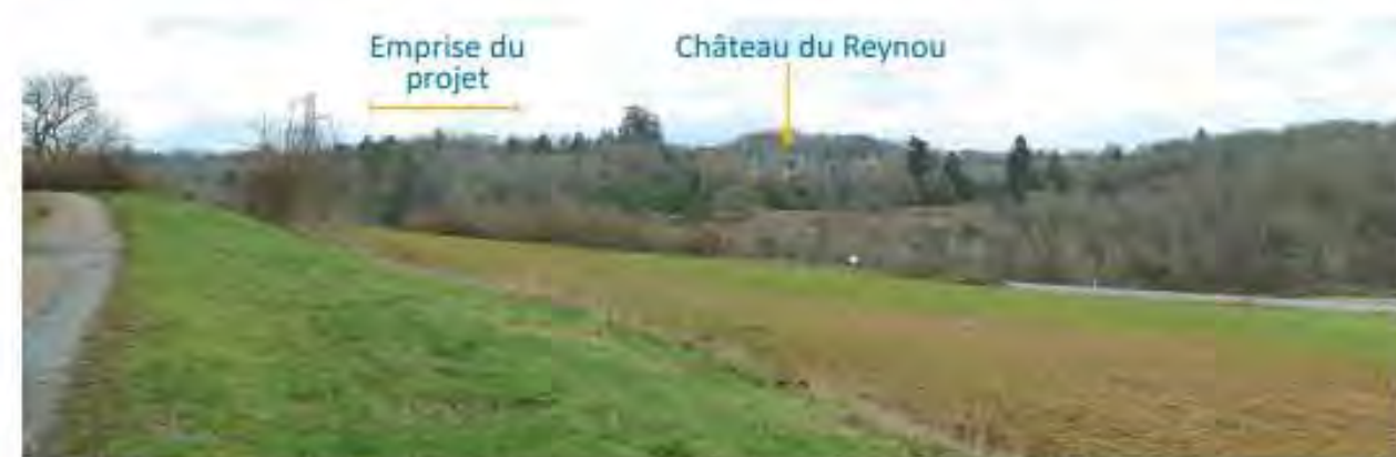
11 Absence de visibilité depuis le lieu-dit le Petit Reynou
