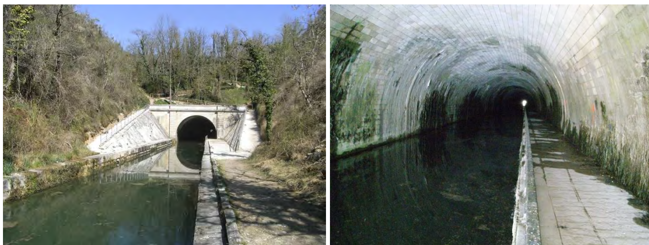
Figure 3 : vues du Tunnel Saint-Léonard
