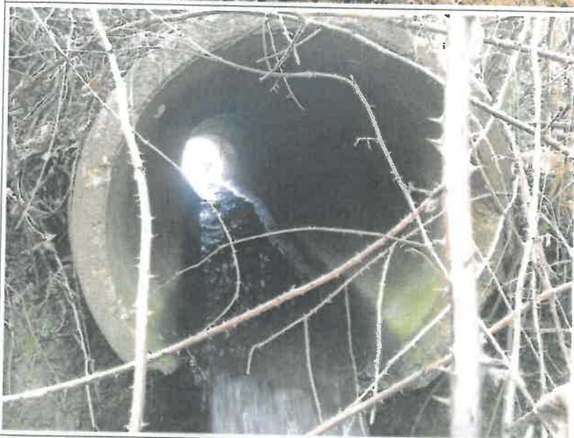
Photographie 5 Partie aval de la buse bétonnée qui sert d'évacuateur de crue (présence de ronces aux abords)
