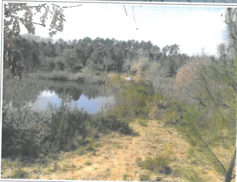
Photographie 2 Vue du barrage en terre depuis la crête
