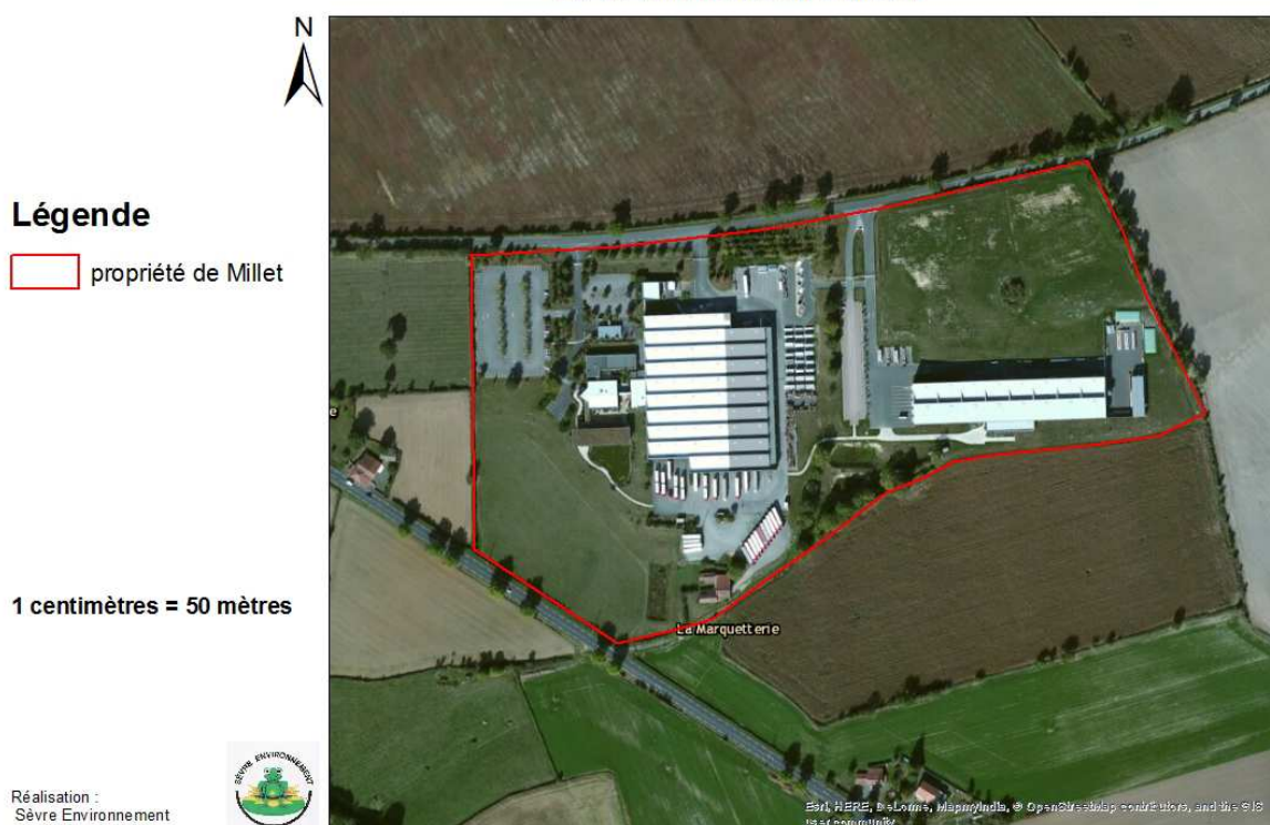
VUE AERIEENNE DU SITE MILLET
