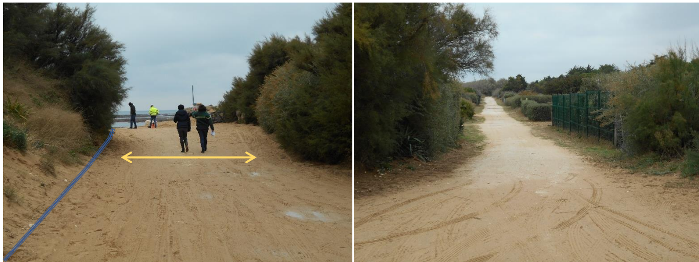
Figure 6 – A gauche : En bleu mise en place ganivelles pour supprimer l'écoulement du sable sur la chaussée (sur la photo le revêtement n'est même plus visible) ; en jaune implantation de la barrière amovible. A droite : route privée des Grands Rocheras permettant le retournement des véhicules qui arriveront jusqu'à la barrière.
