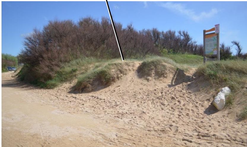
Effondrement de la dune du côté sud de l'entrée
