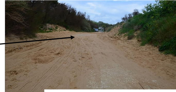
Ensablement important de la voie en arrivant au plus proche de la plage.
