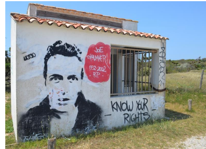
Présence de sanitaires hors d'usage
