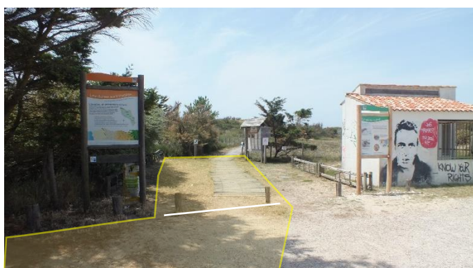
Figure 6 : Sanitaires à démolir (bâtiment) et emplacement du nouveau parc à vélos (encadré jaune). La ligne blanche marque la limite entre le sol naturel et la zone en calcaire)
