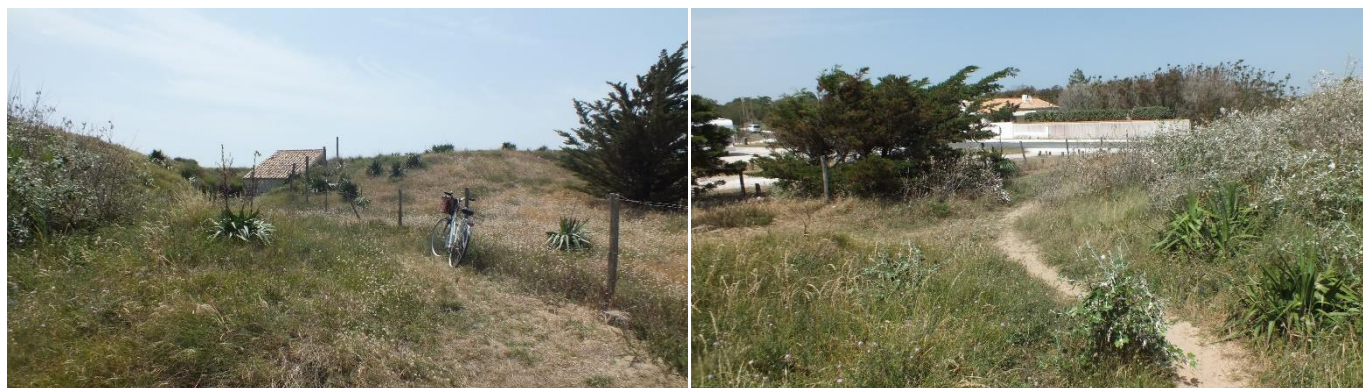
Figure 8 : Accès technique au bâti de l'ouvrage hydraulique. Vélo accroché sur la clôture et sentier sauvage à travers les dunes grises
