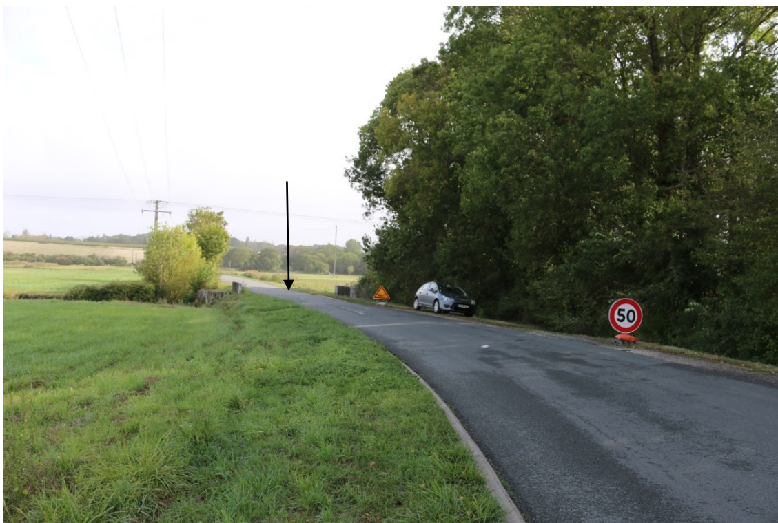
Photo 1 : Vue sur le Pont de la Guitoune
