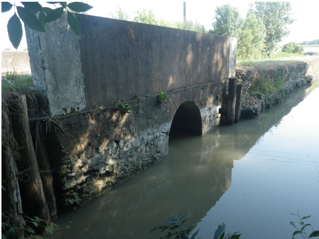
Figure 6 : Photo de l'amont
