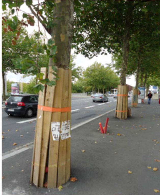
Exemple de dispositifs de protection bois
