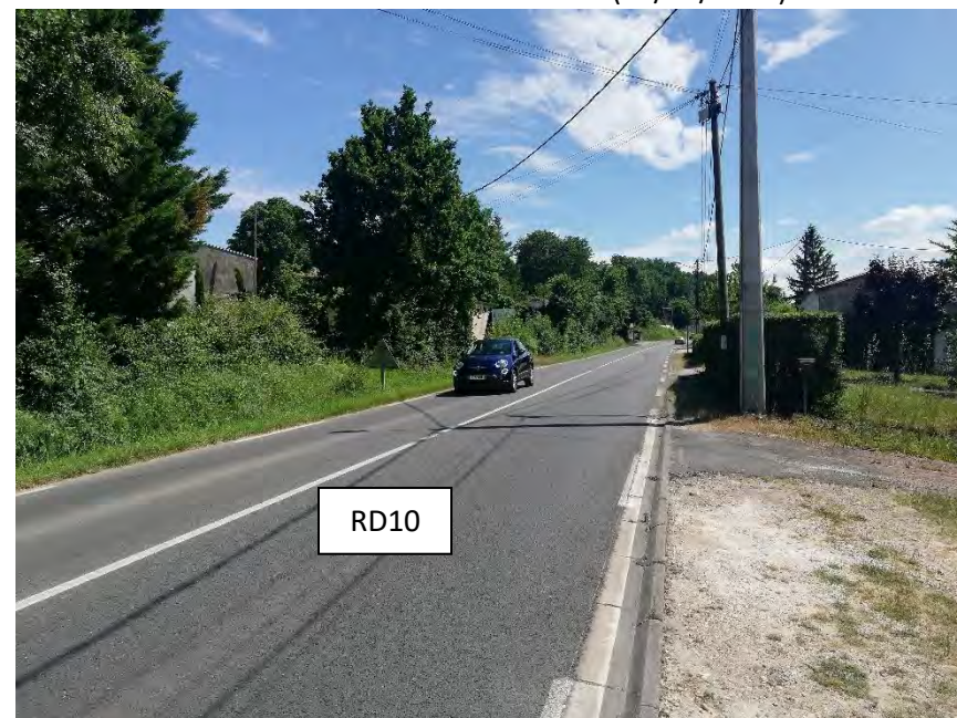
20 : Vue de la RD10 vers le sud (03/06/2020)
