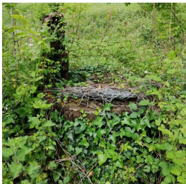
Figure 8 : Puits situé au pied du talus de la RD14
