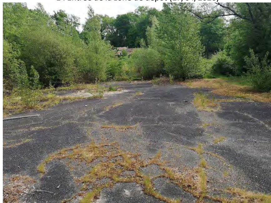
3 : Espace en enrobé (17/04/2020)
