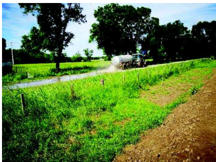
Figure 6. Nettoyage de la voirie après transport de matériaux argileux
