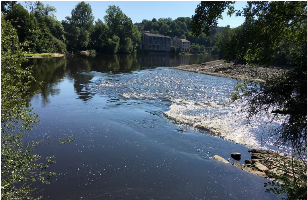
Photo 1 : Seuil de prise d'eau depuis la rive droite
