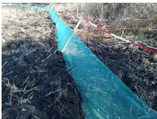
Cloture amphibiens provisoire de type 1 (source : SEGED) et schéma du dispositif échappatoire pour le type 2 (source : Rainette)
