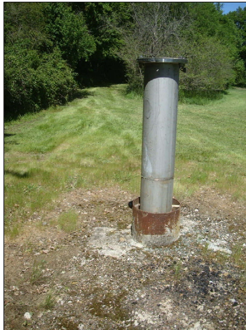
Tête de captage (vue vers le nord/nord-est)
