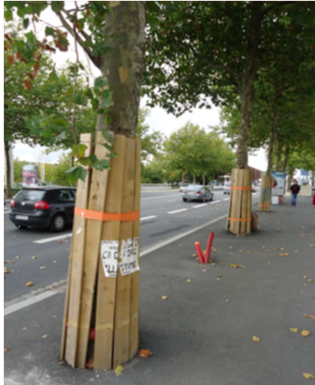
Exemple de dispositifs de protection bois
