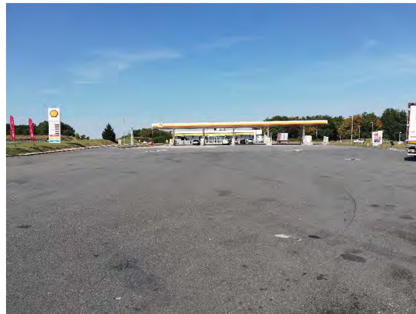
2 : Entrée de la station essence (16/09/2020)
