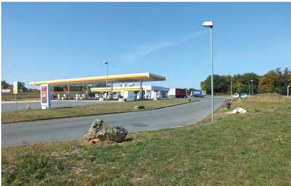
1 : Vue de la station essence (16/09/2020)
