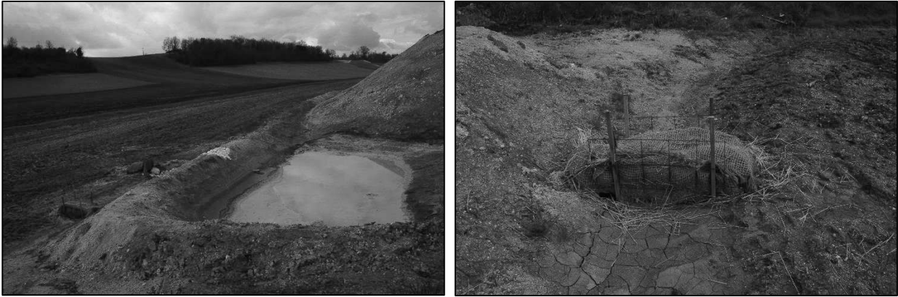
Figure 14 : bassin de décantation temporaire des eaux de ruissellement en phase de chantier avec filtre à paille en sortie
