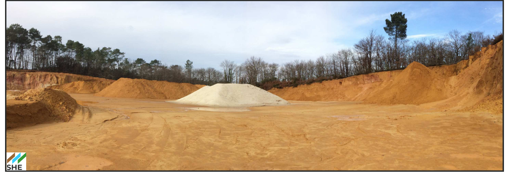
VUE 4 : Aire de stockage des matériaux en partie Nord du site
