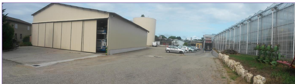
Photo n°1 : Vue de la zone depuis le Sud-Est
