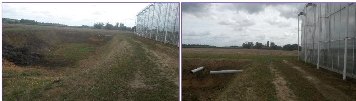
Photo n°4 : Vue du bassin de rétention existant sur le site
