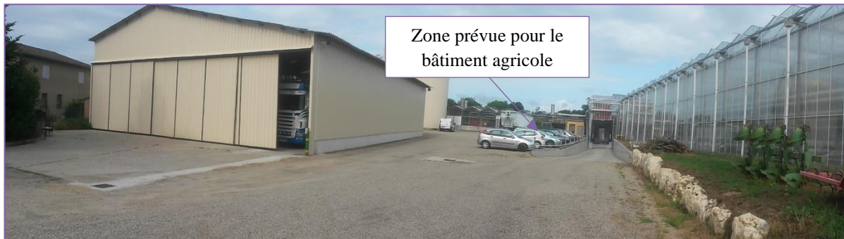
Photo n°1 : Vue de la zone depuis le Sud-est
