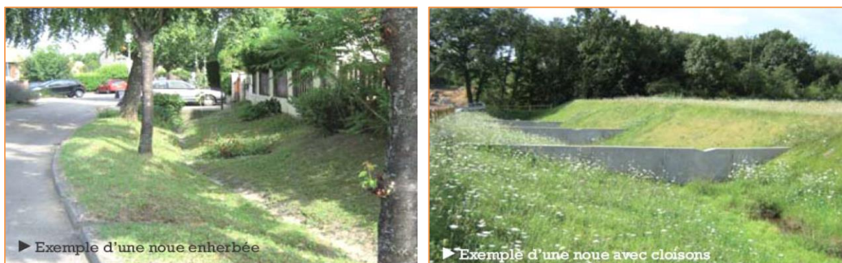
Figure 28 : Exemples de noues
