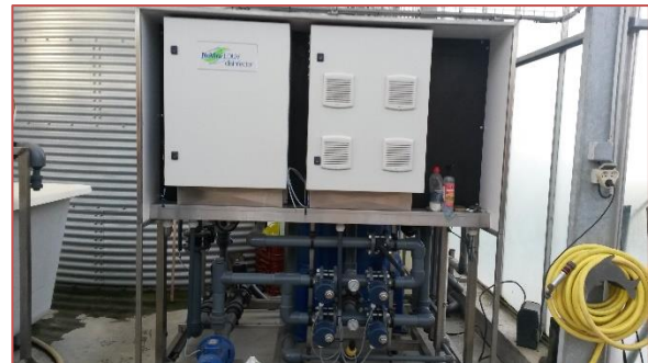
Station UV en intégralité (lampe UV situées sur le côté droit)
