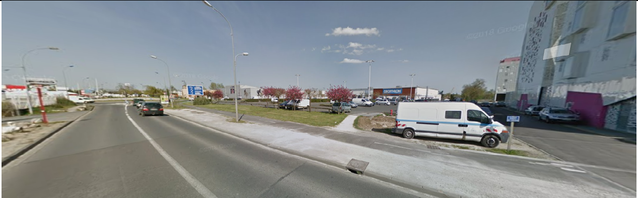
1 : Vue générale du site dans son environnement depuis l'avenue Mirieu de Labarre vers le nord-est (GoogleMaps 04/2018)
