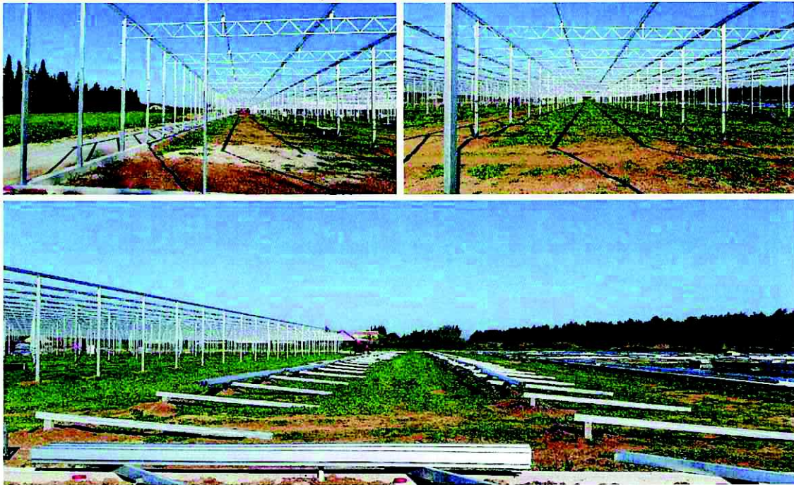
Figure9 : Montage structure d'une serre photovoltaïque - Source : Reden Solar
