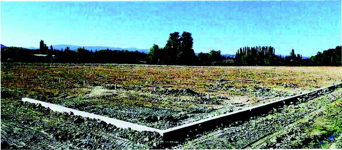
Figure 11 : Fondations béton extérieures (longrine) - Source : Reden Solar
