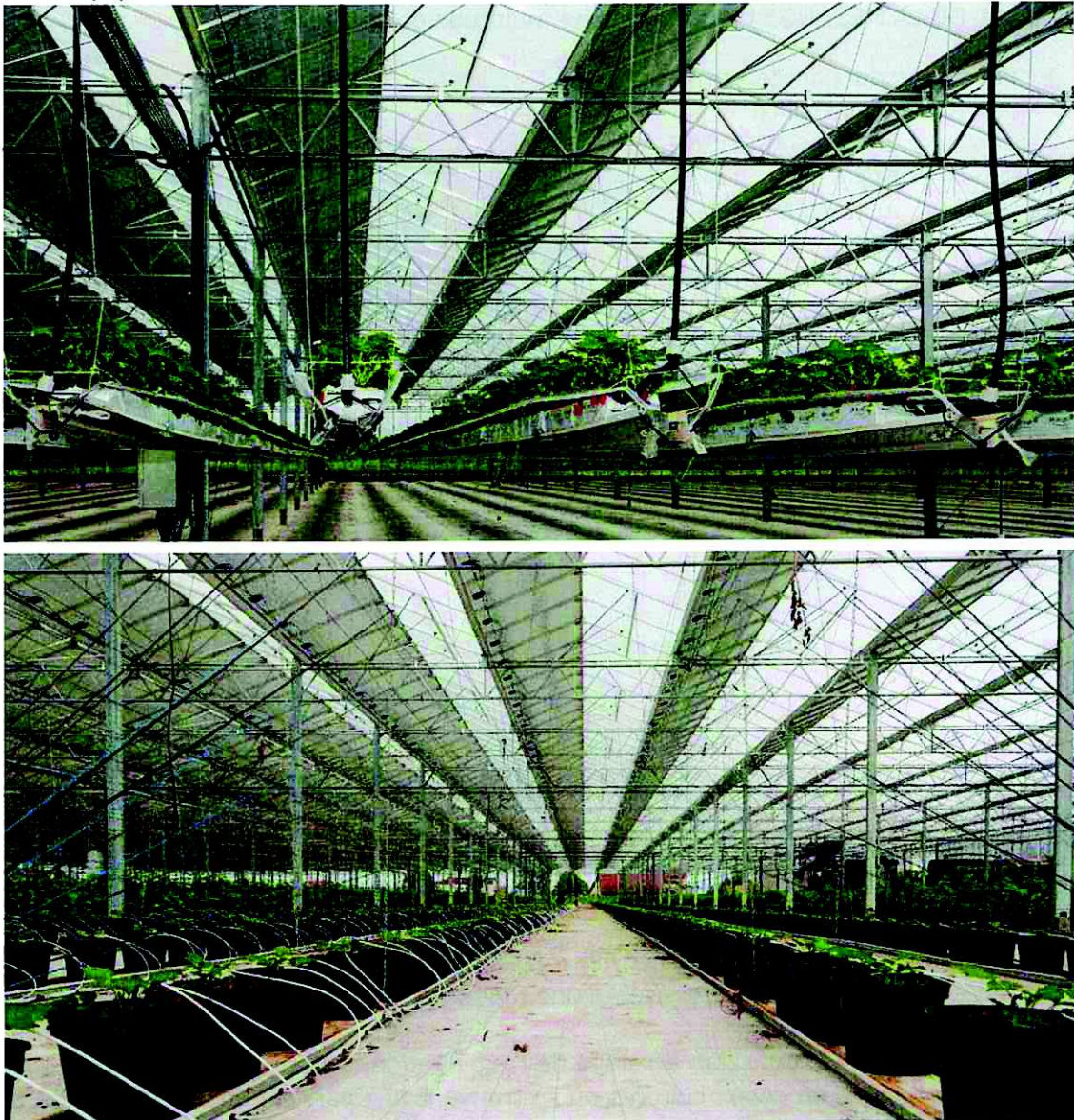
Figure 4 : Exemple de système d'irrigation par goutte-à-goutte, sous serre agricole photovoltaïque - Source Reden Solar
