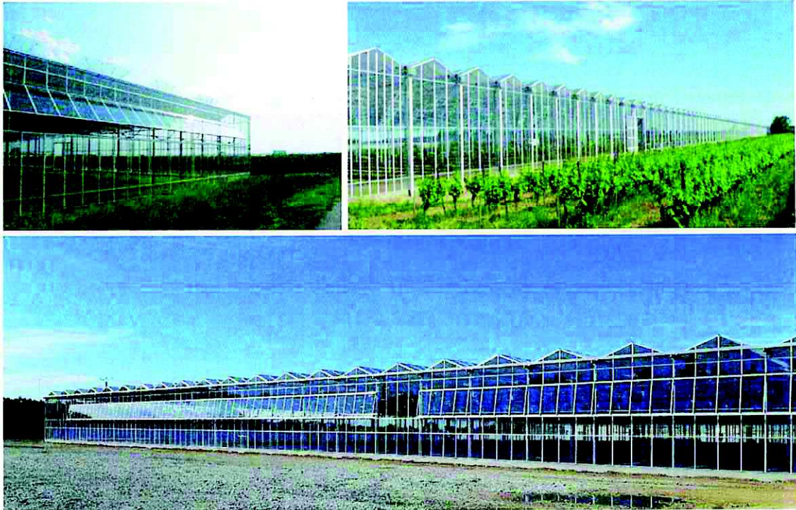
Figure 10 : Ouvrants en façade - Source : Reden Solar
