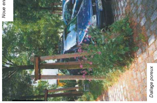
Noue avec cloisons
