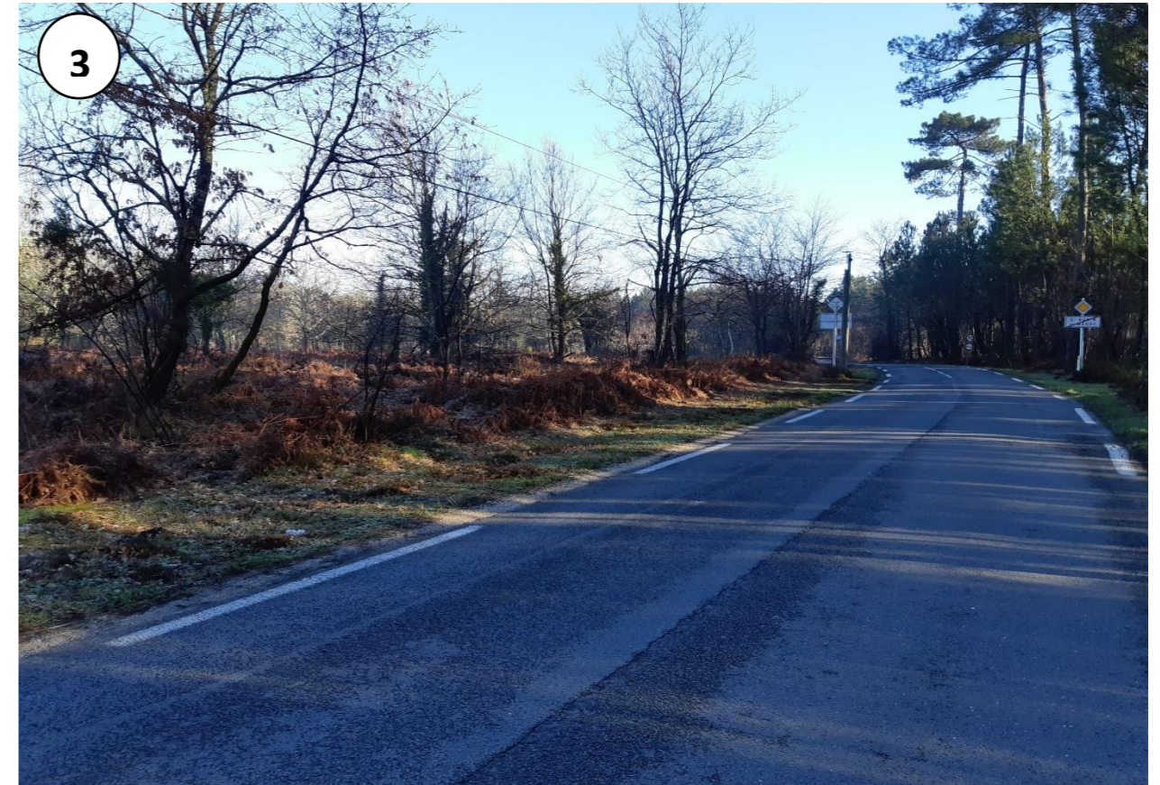
Photographie 1 : Vue de la route de Mounic – Visite du site Février 2020
