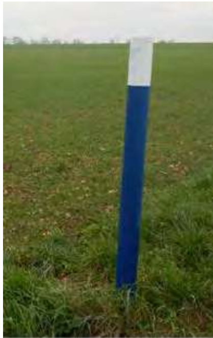
Figure 1. Poteaux permettant de localiser physiquement le passage du feeder
