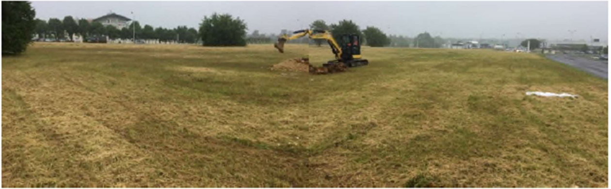
Figure 5 : Vue panoramique du site depuis le Sud-Ouest.
