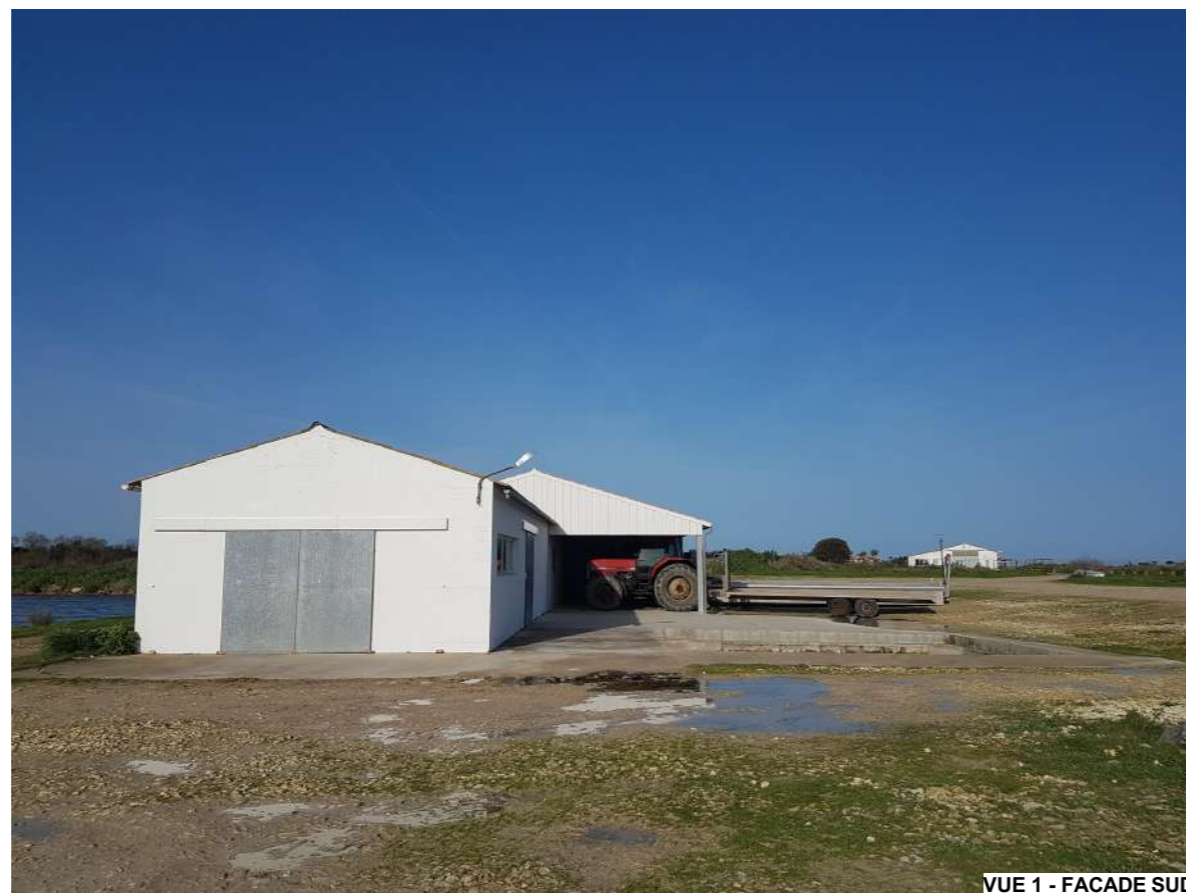
VUE 1 - FACADE SUD
