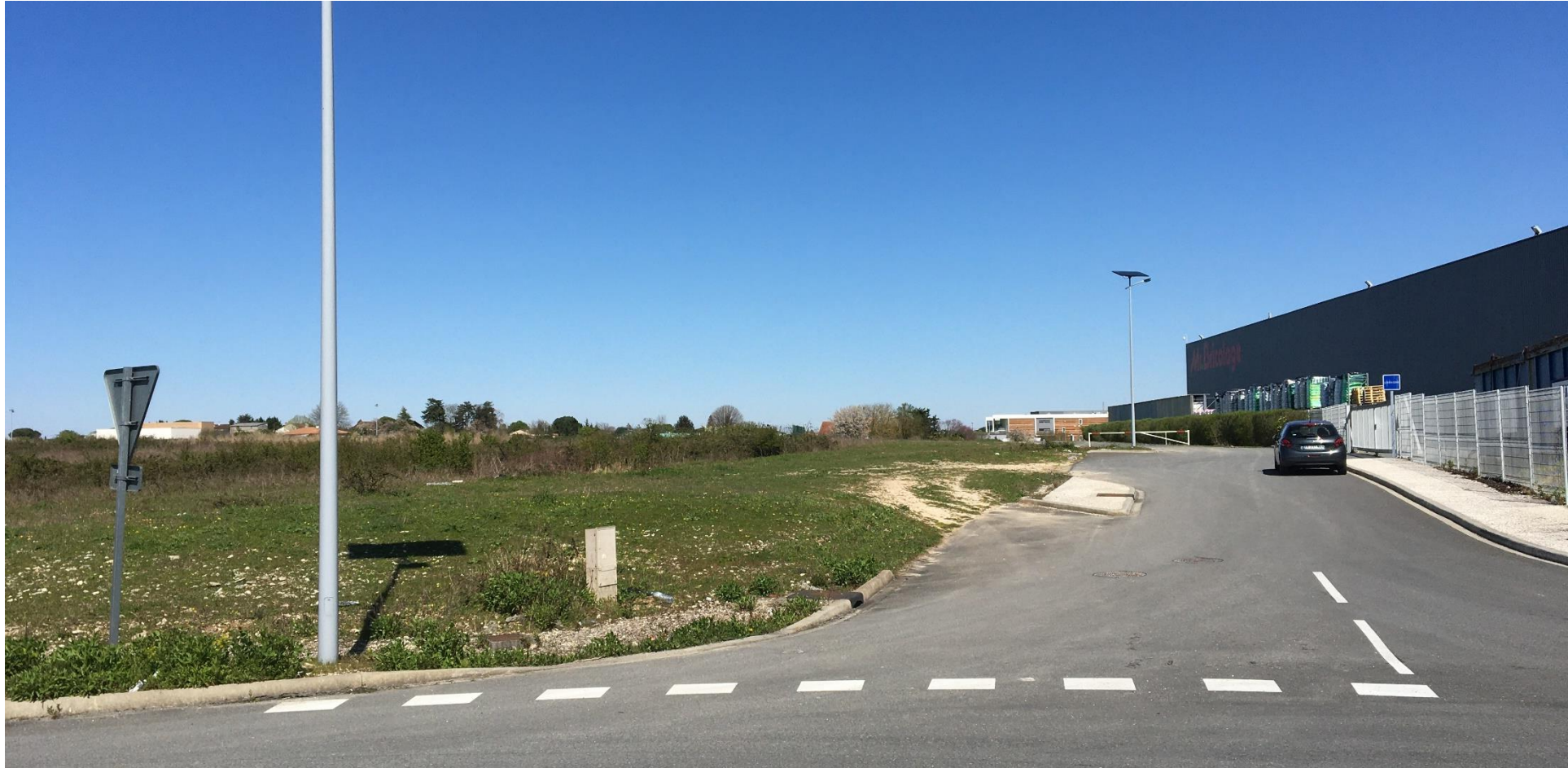
Photographie n°6 : vue depuis le giratoire existant de la ZA Bellevue vers l'accès au futur pont, pignon de Mr Bricolage à droite, hôpital au loin. Date 31/03/2020
