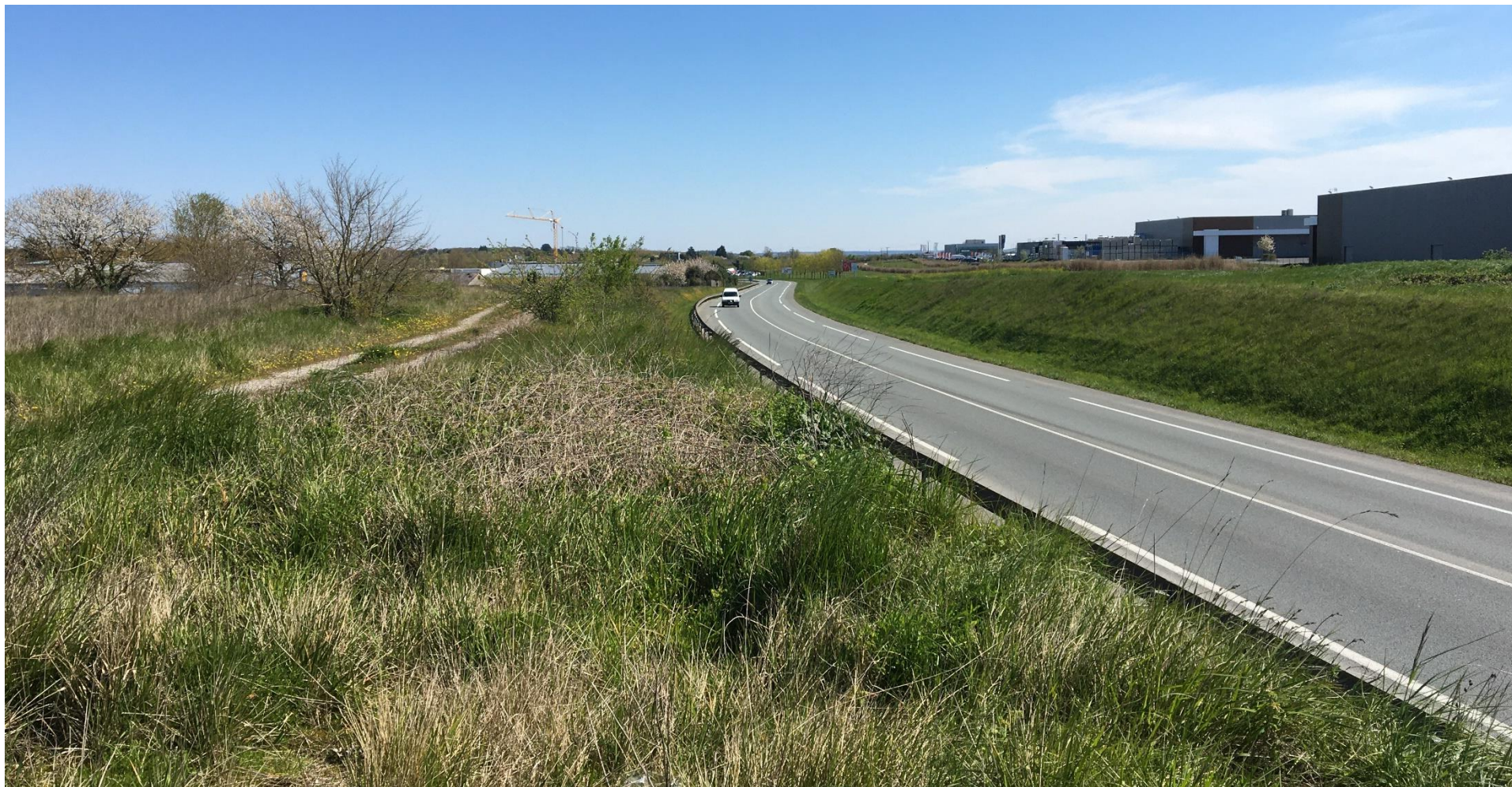
Photographie n°3 : vue de la RN 141 vers l'Est, position de l'emplacement du futur pont et du giratoire à créer. Date 31/03/2020
