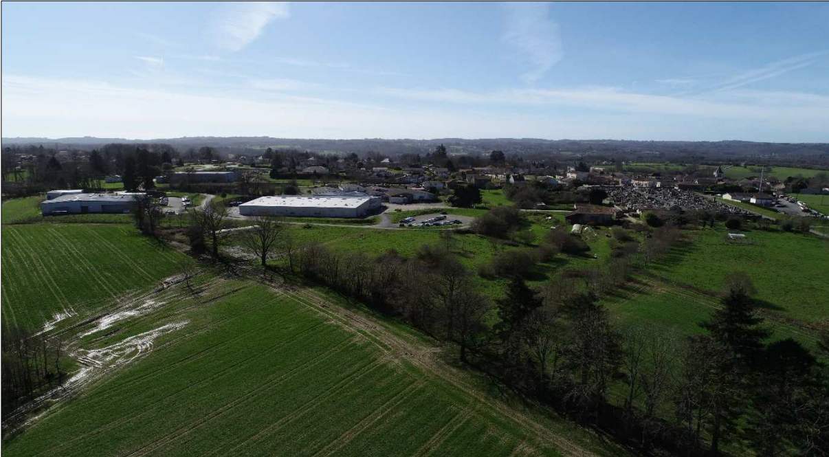
Figure 12 : Vue photographique de la zone industrielle à Oradour sur Vayres (Source : notice architecturale – Bruno CALMES architecte)
