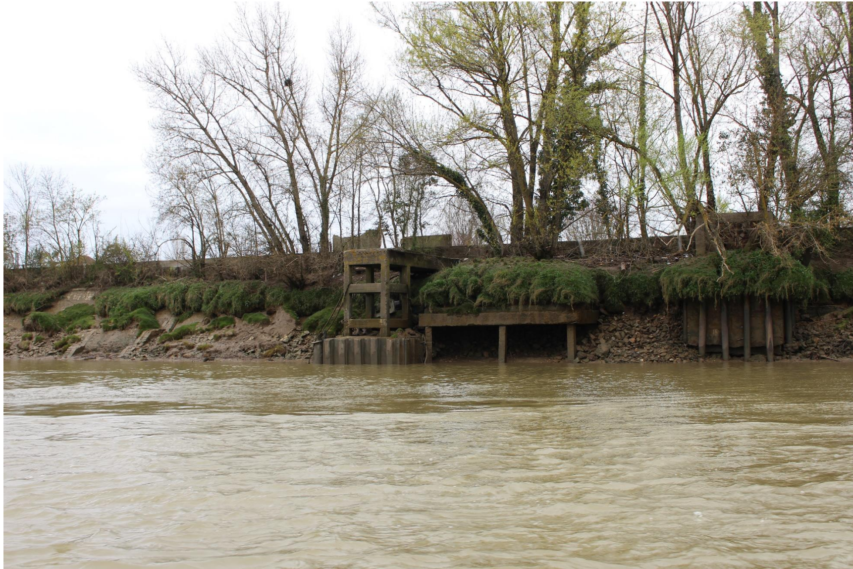
Prise de vue n°2 (Source : Seaport Engineering)
