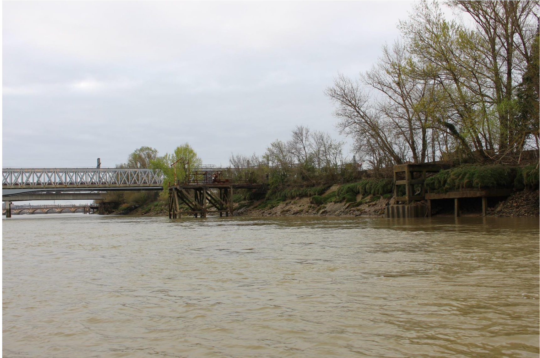
Prise de vue n°3 (Source : Seaport Engineering)
