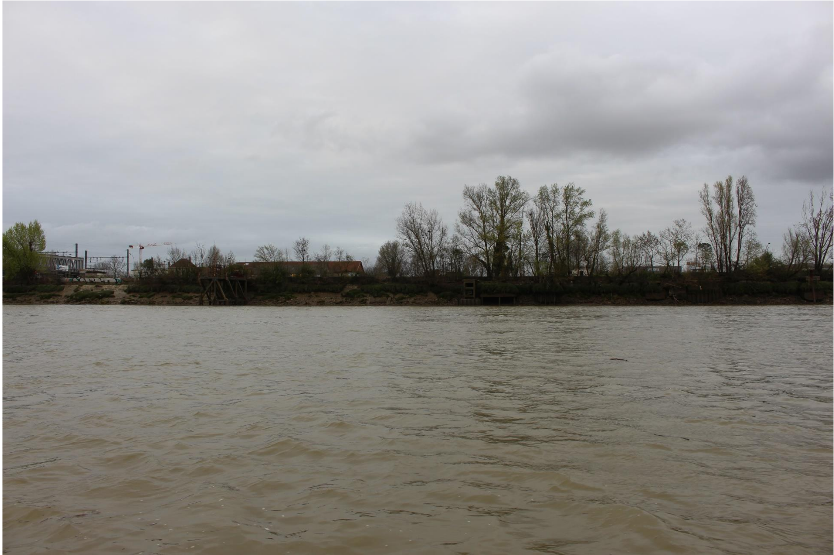
Prise de vue n°1 (Source : Seaport Engineering)
