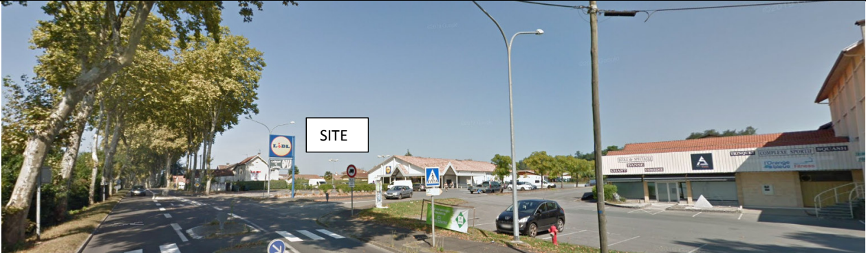
2 : Vue générale du site dans son environnement depuis la route de Bayonne en direction du nord-ouest (GoogleMaps 09/2018)
