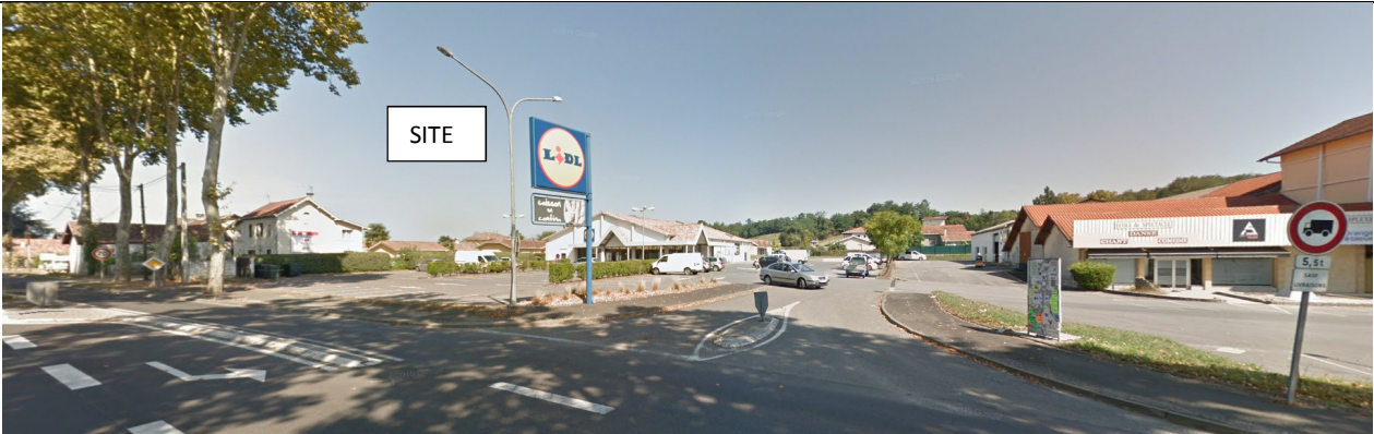
3 : Vue générale du site dans son environnement depuis la route de Bayonne en direction du nord (GoogleMaps 09/2018)
