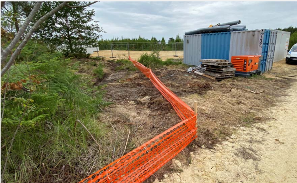
Figure 11 : Exemple d'une mise en défend des enjeux écologiques
