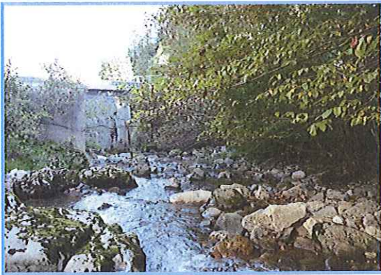
Vue générale de la station (depuis l'amont)
