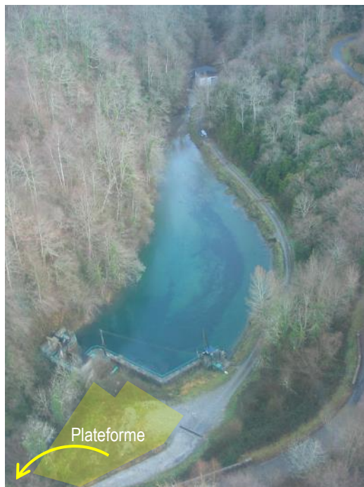
Figure 12 : Point de réinjection dans le Gave du Valentin au barrage d'Espalungue
