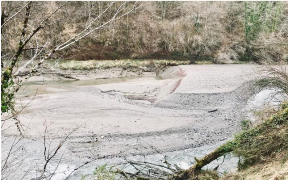
Figure 7 : Photographie de la retenue d'Iscoo à la cote 786 m NGF (2020)
