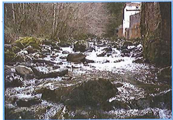
Vue générale de la station (depuis l'aval)
