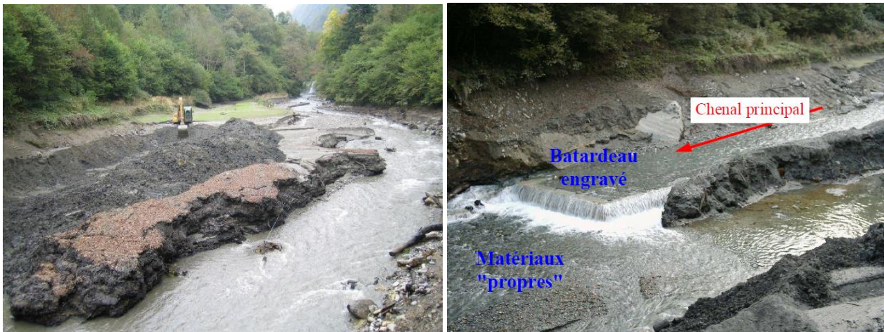
Figure 15 : Retenue d'Iscoo en cours de vidange (2007)
