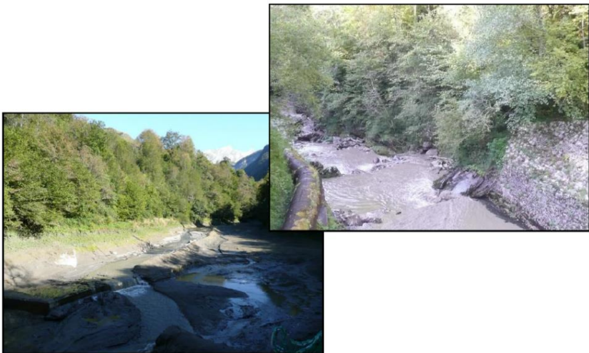
Figure 17 : Retenue d'Iscoo en cours de vidange (2008)
