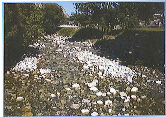
Vue vers l'aval
