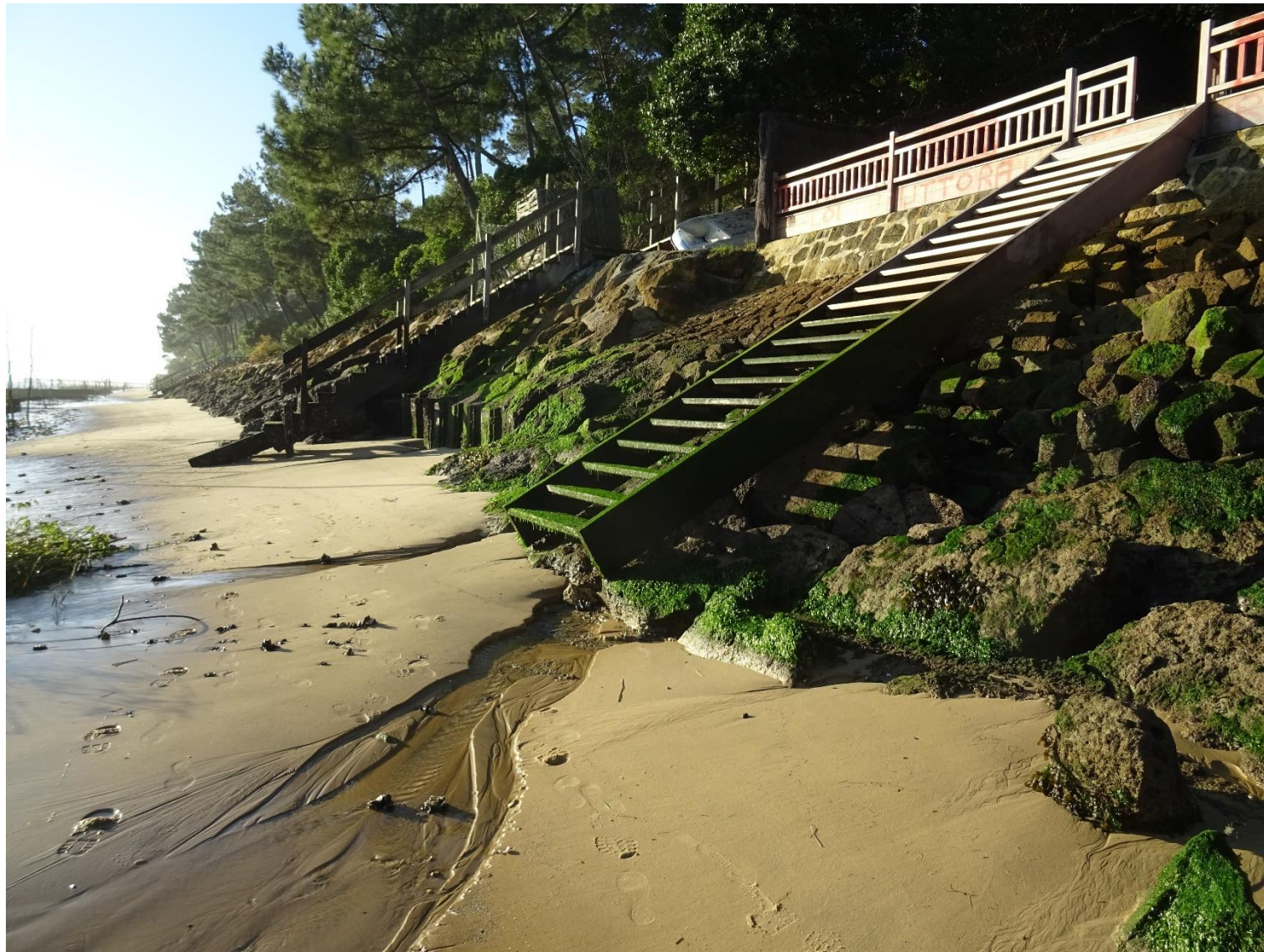
Figure 7: Prise de vue n°4 (source : CASAGEC INGENIERIE, ,09/01/2020)
