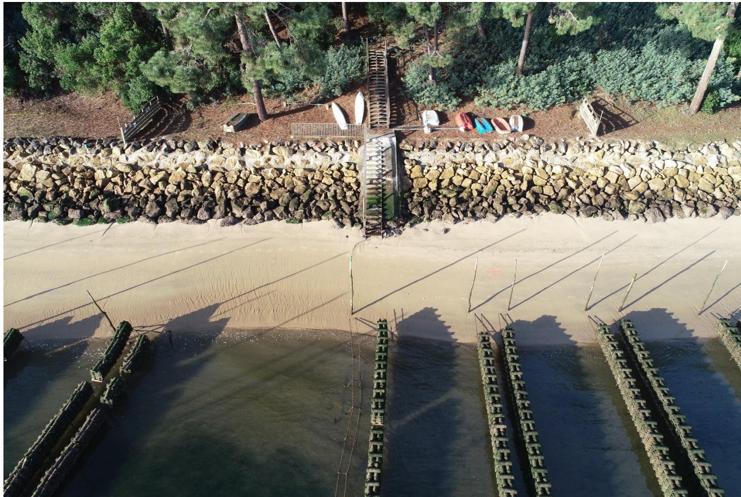
Figure 6: Prise de vue n°3 (source : CASAGEC INGENIERIE, ,09/01/2020)
