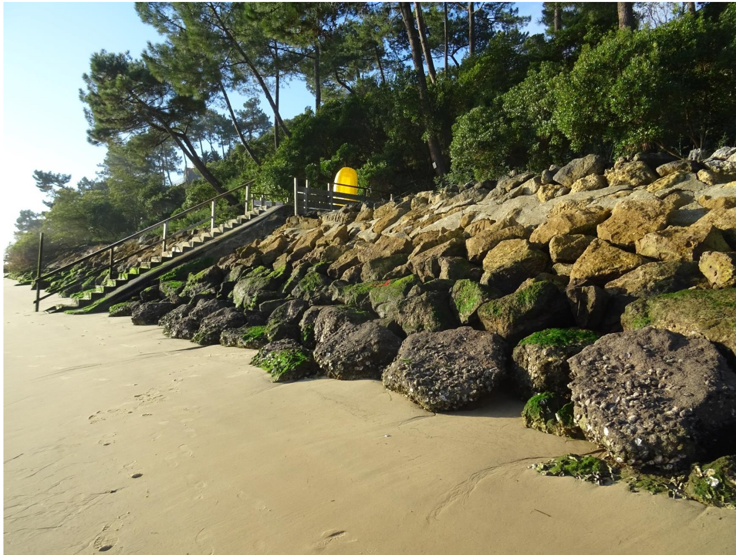
Figure 5: Prise de vue n°2 (source : CASAGEC INGENIERIE, ,09/01/2020)
