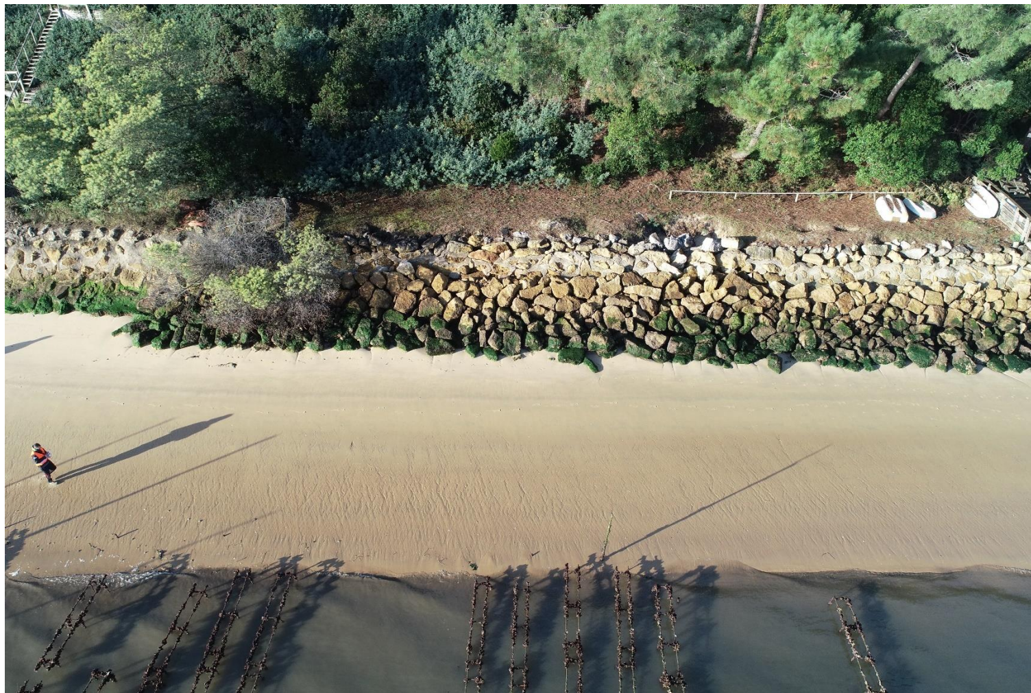
Figure 4: Prise de vue n°1 (source : CASAGEC INGENIERIE,09/01/2020)
